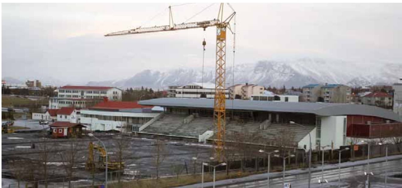
Staða framkvæmda að Hlíðarenda um miðjan desember 2006.
