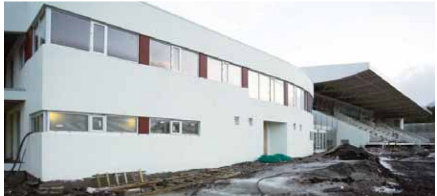
Glæsileg mannvirki að rísa. Ný tengibygging og 1500 manna stúka við nýjan væntanlegan aðalkeppnisvöll að Hlíðarenda. Mynd tekin um miðjan desember 2006.
