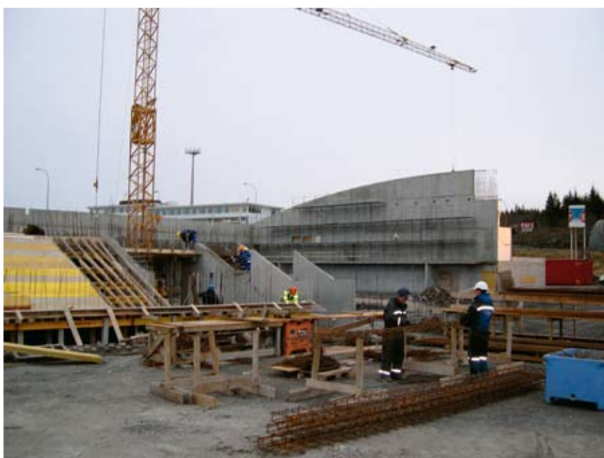
Nýtt og glæsilegt íþróttahús rís hratt.
