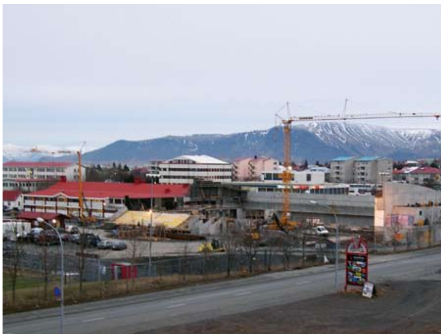
Staða framkvæmda að Hlíðarenda um miðjan desember 2005.
